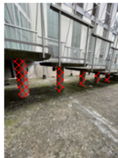
coffrages perdu en amiante ciment des poteaux de soutien des escaliers de liaison
